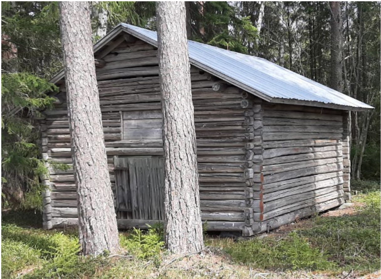
Simpukkaranta, alueella oleva hirsinen varistorakennus, n. 20 m 2 .
